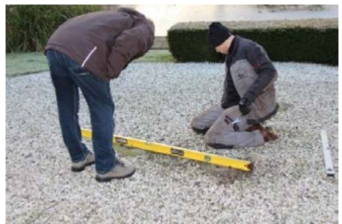
De drie poeren waarop de zonnewijzer staat worden nog gecontroleerd met een lange waterpas. Dit leert ons dat de afwijking van de poolstijl niet veroorzaakt wordt door verzakkingen van deze poeren. Alles is nagenoeg waterpas.
