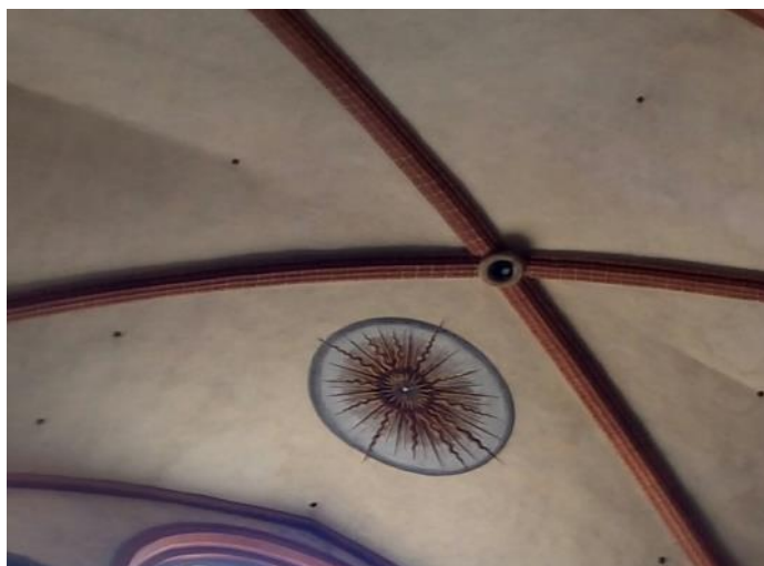
Afbeelding 2 Het lichtpunt in het dak; detail
