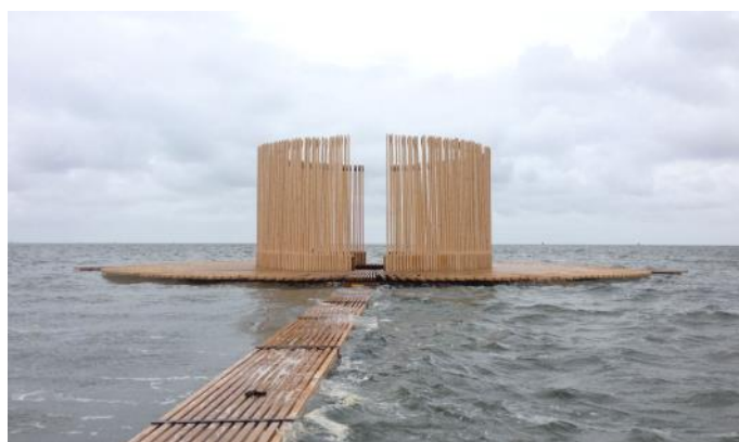
Fig. 3. De installatie bij vloed: de rugleuning is rechtop komen te staan. Bron: [1].
