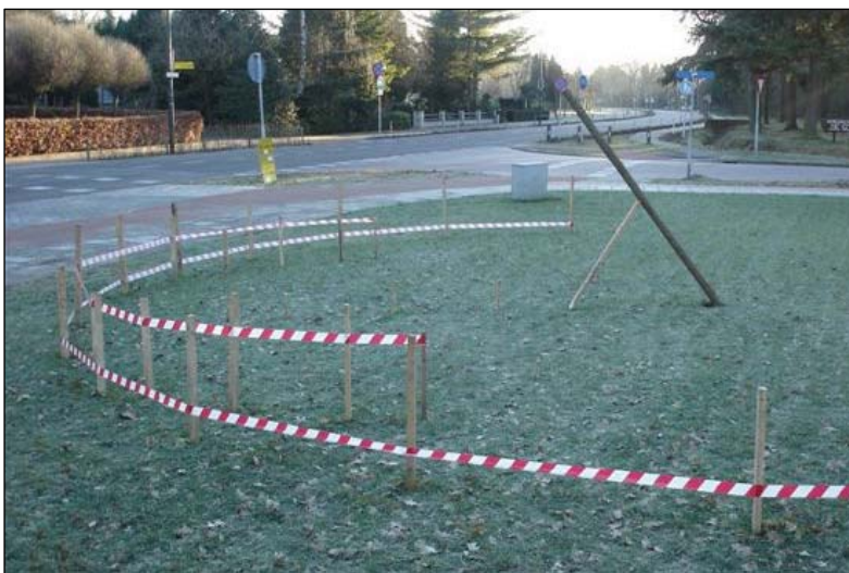
Fig. 2. Het eerste model: de provisorische poolstijl en de urenring van 10 meter middellijn.
