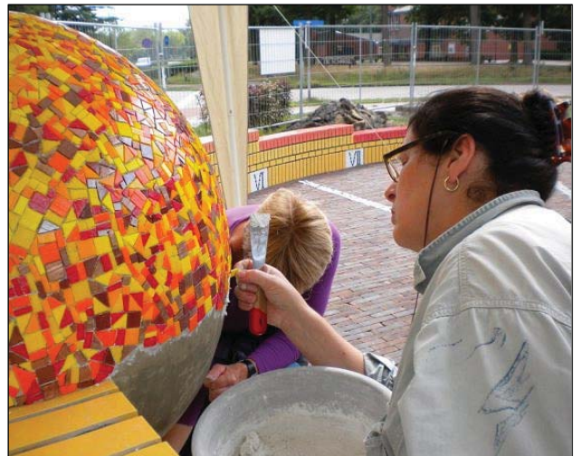
Fig. 6. De mozaïeksteentjes worden aangebracht. De lastige onderkant moet hier nog komen. De uurnummers, in Romeinse cijfers, zijn ook in mozaïek aangebracht en op de achtergrond zichtbaar.
