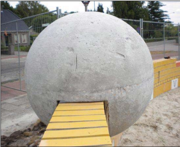
Fig. 5. De betonnen zonnebol is gegoten met een uitsparing die precies over de muur past.
