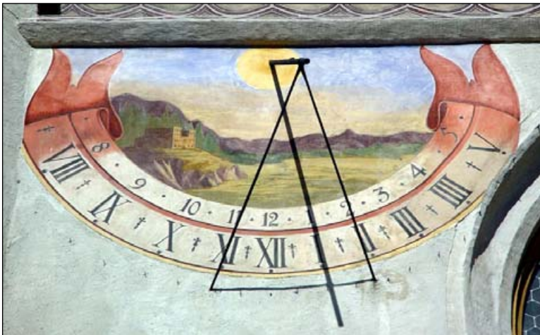
Fig. 1. Iets westelijk afwijkende zonnewijzer op de parochiekerk van Hall in Tirol (Oostenrijk). Er zijn geen uurlijnen, maar twee series uurpunten. De schaduw van de dubbele ondersteuning van de poolstijl valt in dit geval buiten de wijzerplaat. Foto: Paul Hofmann, Innsbruck.
