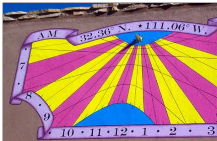
Fig. 3. Oostelijk afwijkende zonnewijzer van John Carmichael in Tucson (Arizona, USA). De gnomon is een brede messing kegel met een scherpe punt. Deze wijst hier 9 uur op de herfstequinox. Door de vorm heeft de schaduw wel iets van de wijzer van een klok: lang en taps toelopend. Foto: John Carmichael.
