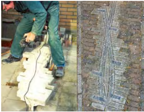
Het baksteenpatroon in beton met de kleine lus. Hier wordt de baksteenrand bijgeslepen door Wybe Westra.
