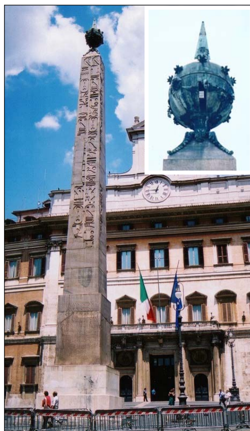
Fig. 2. De obelisk voor het parlamentsgebouw op de Piazza Montecitorio. De meridiaanlijn loopt tot in de ingang, waar de twee agenten staan. Inzet: de gnomon, gezien vanaf de noordzijde. De bol heeft een gat aan de bovenkant en een spleet aan de onderkant, met roostertjes tegen de duiven.
