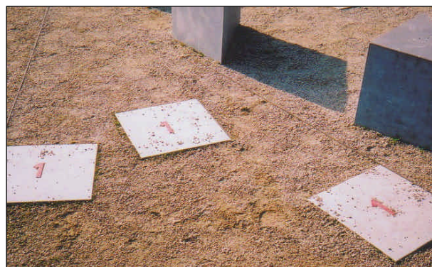
Fig. 5. De kunststof cijfers laten soms los van de keramische tegels, met raadselachtig resultaat.
