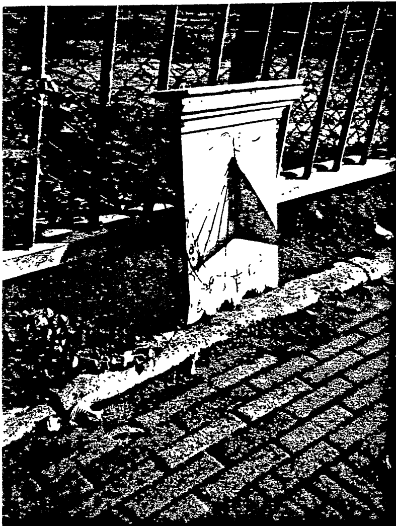
voor de restauratie
