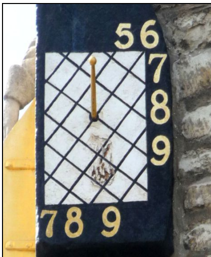
Fig. 5. De foto van de oostwijzer is in verticale richting tot 76% verkleind. Equinoxlijn en 6-uurs lijn staan daardoor haaks op elkaar en de uurlijnen maken een hoek van ca. 52° met de horizontaal.
