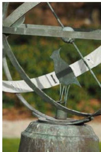
Fig.6. a. De voet van de armillairsfeer met kievit, schuifbevestiging uurring en hoekverstelling evenaar. b. fixatie van de meridiaanring met klinknagels naast de voet van de kievit.
